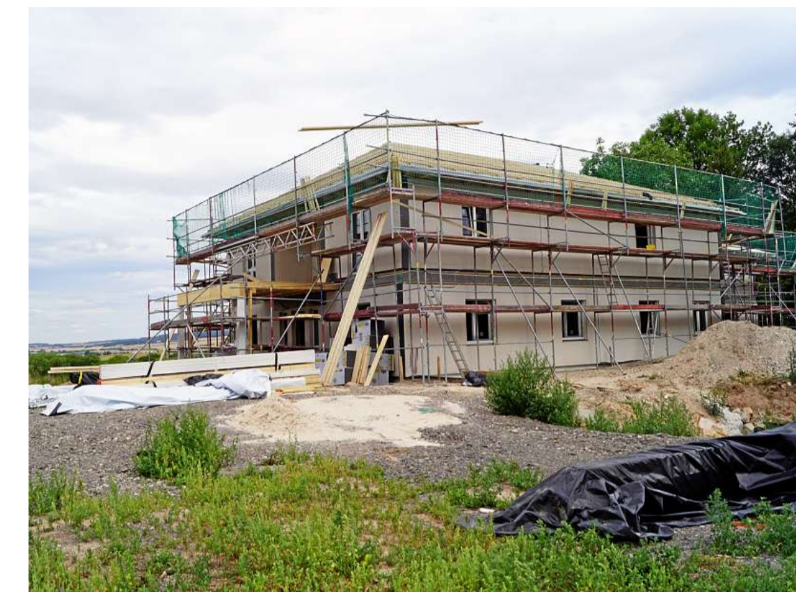
Die Handwerker waren fleißig: Der Rohbau des ersten Gebäudes steht.
